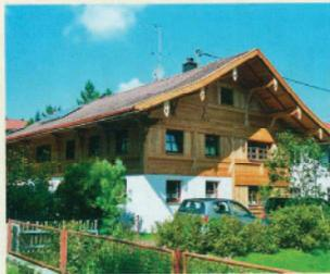
Mit dem DHD Verputzsystem und einer Erweiterung des Vordaches wurde nicht nur eine optische Verschönerung, sondern eine Einsparung von 75 Prozent Heizenergie erreicht.
